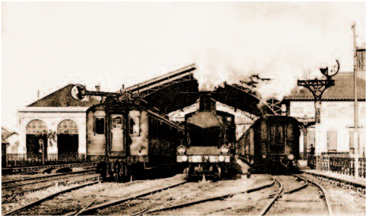
La stazione di Cornavin, a Ginevra. Partenza in direzione della Francia.
